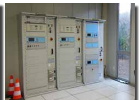
Poste Ouvert, Réalisation BI, 2 départs, Automate de poste
